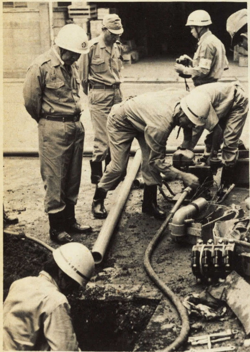
破損力所を掘削してビニール管に接続
