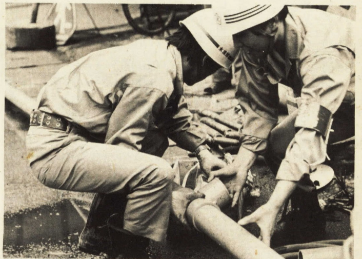
ビニール管を路上に配管
