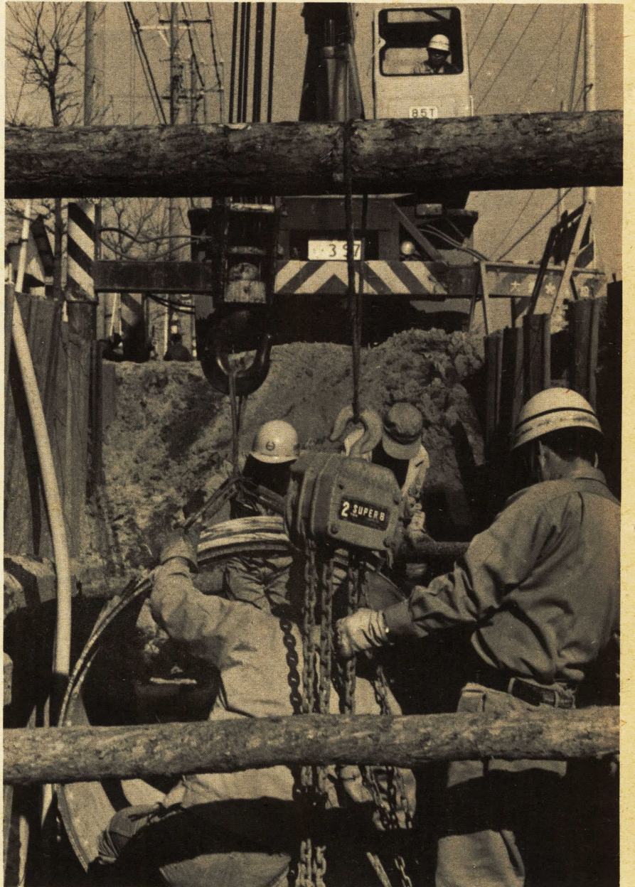
将来の需要に合わせて大径の導水管が埋設される
