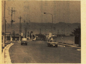
川東地区中央交差点交通信号機設置工事... 安全施設など配慮
