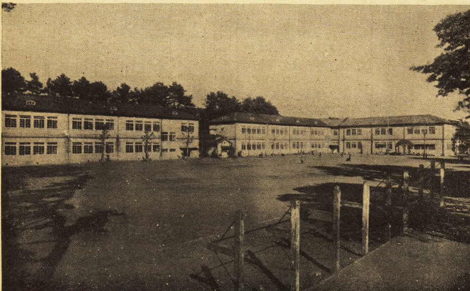
本町小学校は昭和40年から鉄筋化に着手
