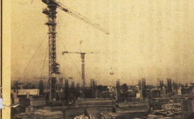
進む新庁舎の建設
