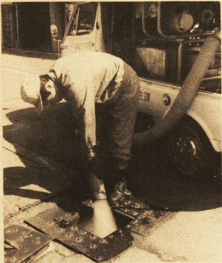
→マンホールなどは噴霧消毒
