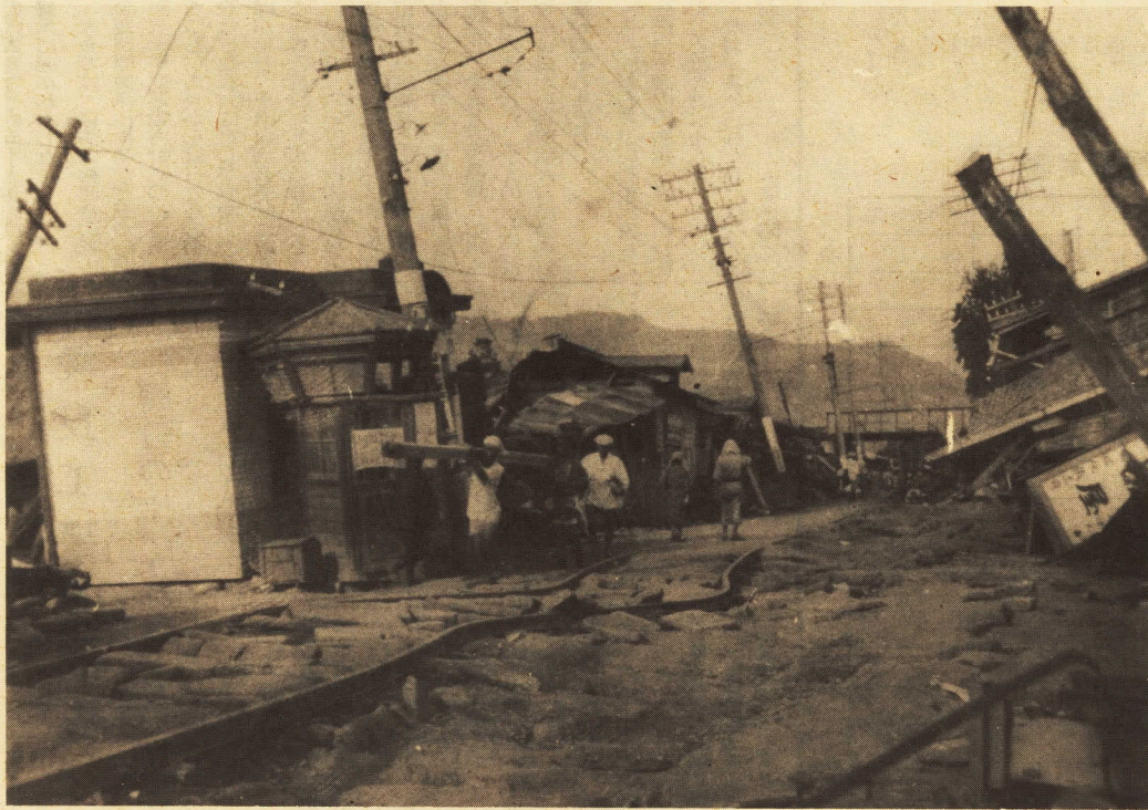
関東大地震による山角町通り【いまの南町】の被害
