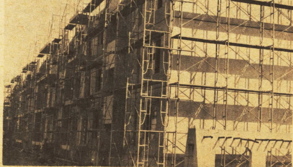
建築中の市営住宅
