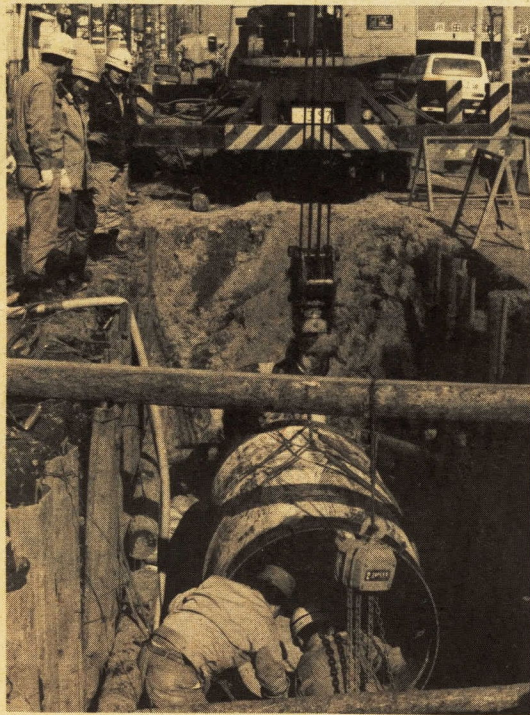
水道管の敷設工事
