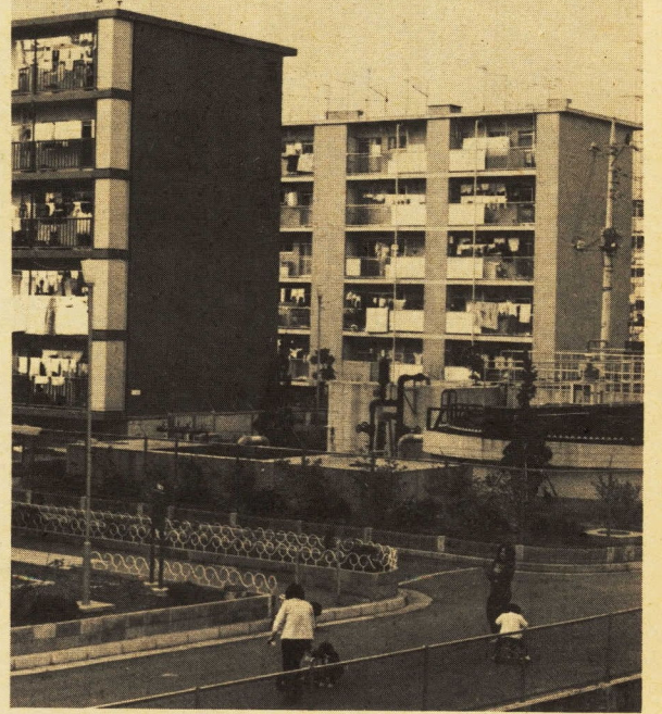
中層耐火構造の市営住宅
