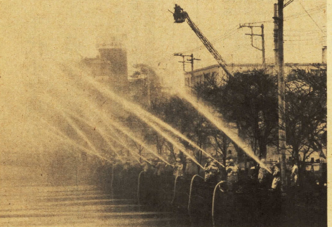
ポンプ車によるいっせい放水
