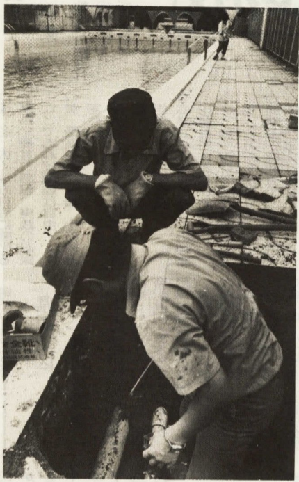
給水されると、すっかり私らしくなるが、まだ、給水管や排水に故障がないか調べてもらう
