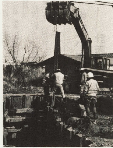
鴨宮区画整理地内の下水道工事
