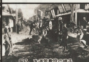
昭7. 水道管敷設の様子
