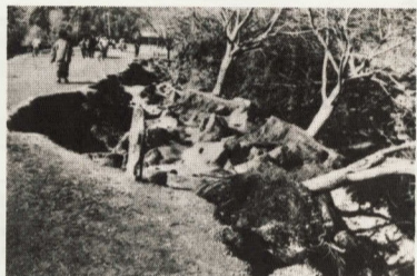
お堀端の地割れの様子
