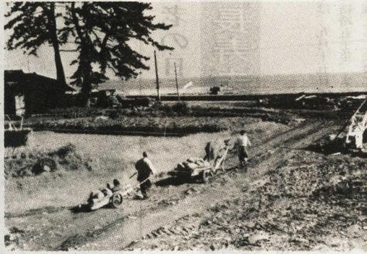
漁港建設の石材を馬力・人力で運ぶ(昭和30年)
