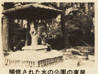
補修された水の公園の東屋
