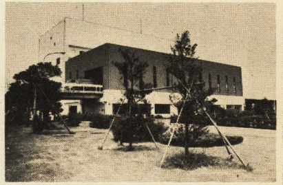
最新設備を誇る清掃工場
