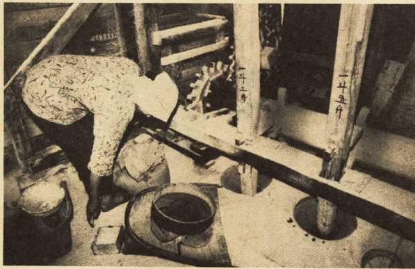
水車の回転を上下運動に変えて米をつ きます(水車小屋の内部)
