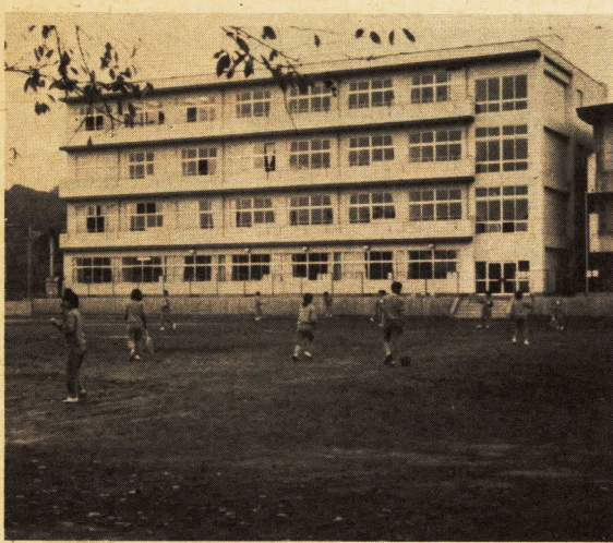
完成した新校舎
