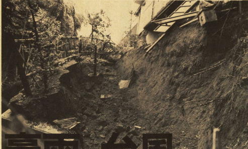
がけ崩れは、雨によって土砂がゆるみ、土砂が崩れ落ちる。
