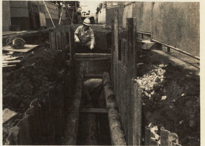
下水道管の埋設工事にご協力を
