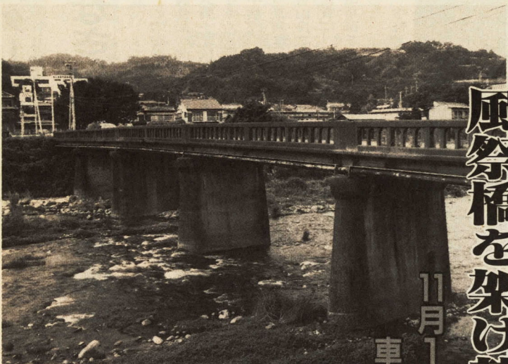
取り壊される風祭橋
