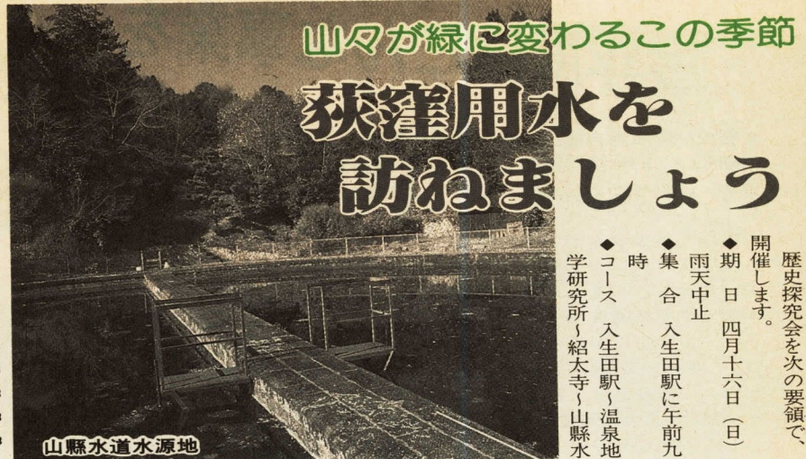
山縣水道水源地
