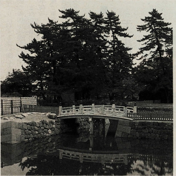
整備が進められている二の丸中堀
