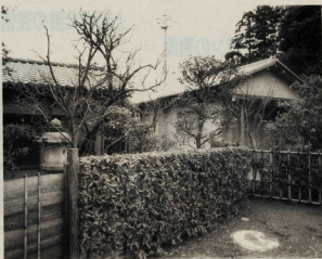
新築された茶室附属棟(右側の建物)。左は「茶園庫」
