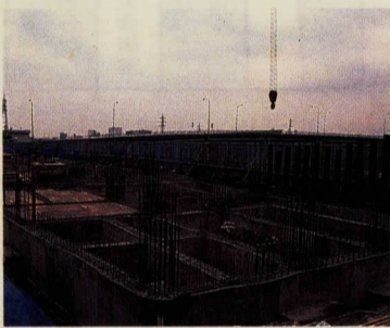
基礎工事中の新消防本部
