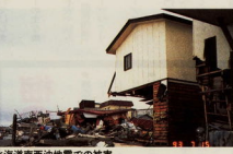
北海道南西沖地震での被害
