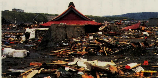
北海道南西沖地震の被害状況
