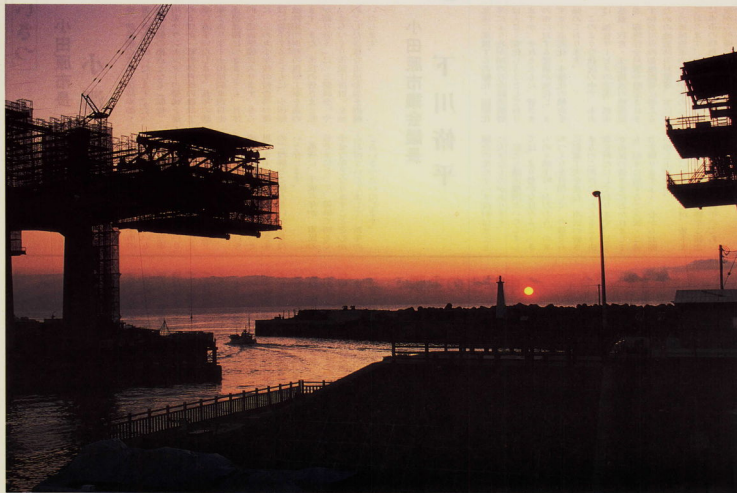
西湘バイパス延伸工事が進む漁港
