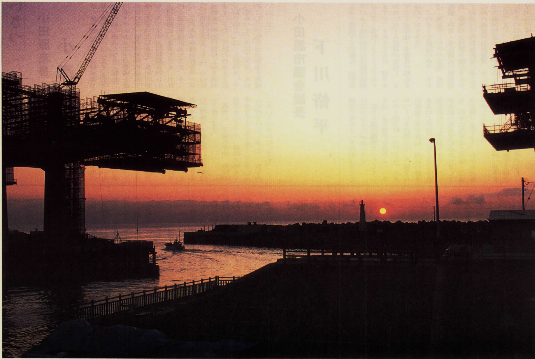
西湘バイパス延伸工事が進む漁港
