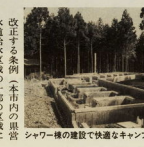
シャワー棟の建設で快適なキャンプを
