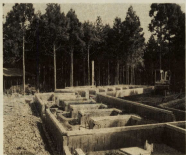
シャワー棟の建設で快適なキャンプを
