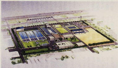
高田浄水場は、第三期拡張事業に基づき、総工費約1億4,800万円をかけて昭和44年に竣工しました。平成4年度には、浄水場敷地内に水道局庁舎も完成しました。浄水場の現在の施設能力は、一日最大7,800m³です。この量は、一日最大120,000m³の浄水能力を備えた施設の完成を想定しています。
