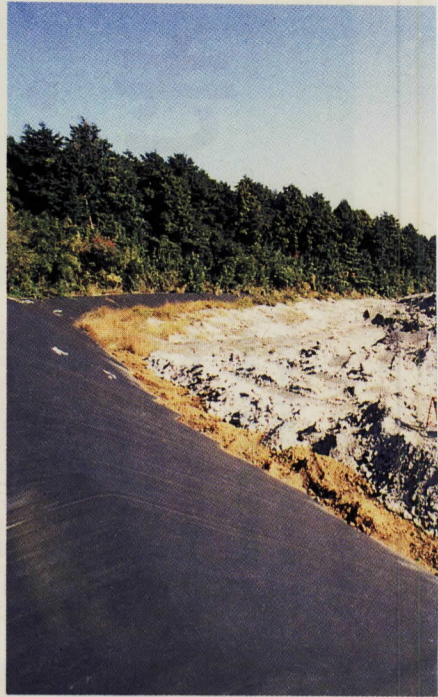
埋め立てが満杯に近づいた処分場
