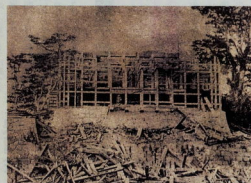
廃城により解体中の天守閣(明治1年)
