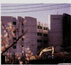
建設が進むルビーセンター
