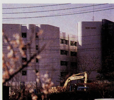
建設が進むルビーホーム
