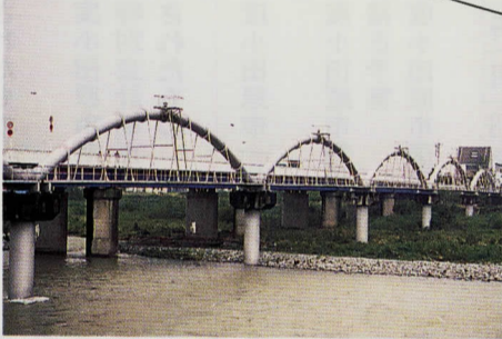
▲中河原配水池から栢山方面へ配水
