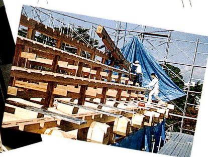
銅門の復原工事がよいよ櫓門部分の建築を開始
