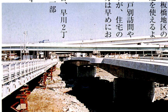
下水道事業と一体となって工事が進む早川橋
