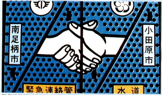
緊急連絡管ボックス。道路上で見かけたことがありますか。
