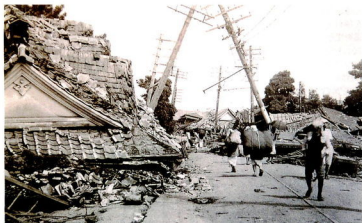
倒壊した家々と東海道(当時 幸) 東海道の家々も軒並み倒壊。傾いた電柱や低く落ちた屋根が、被害の大きさを語っている。
