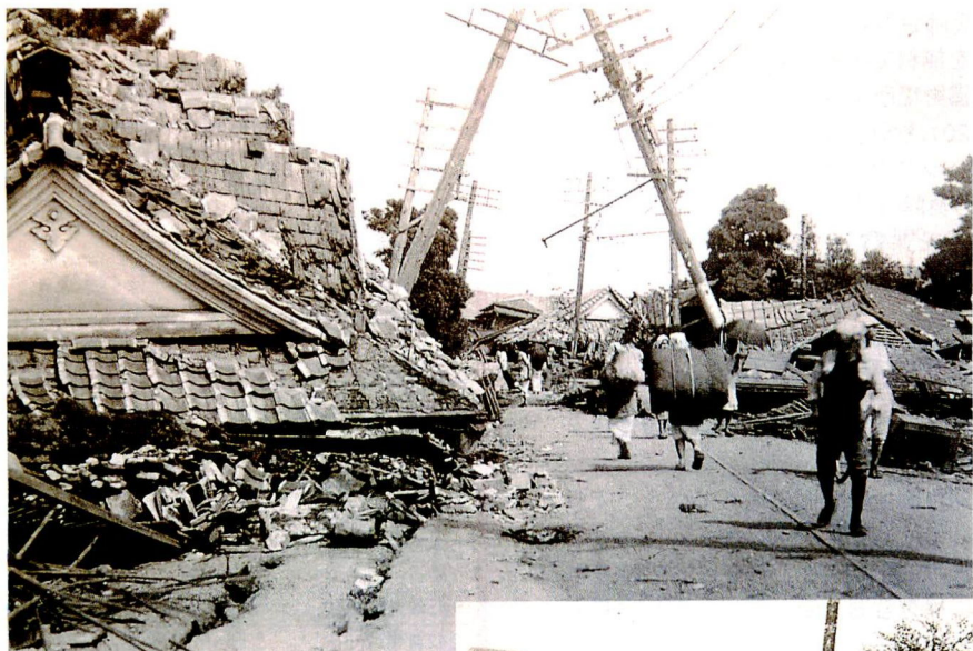
倒壊した家々と東海道(当時 幸) 東海道沿の家々も軒並み倒壊。傾いた電柱や低く落ちた屋根が、被害の大きさを語っている。
