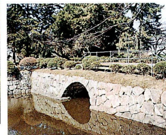
▲馬出門土橋 (うまだしもんどばし) 二の丸の正面入口。通称「めがね橋」とも呼ばれるが、これは昭和になってからトンネルにしたため。橋は石垣でできている。
