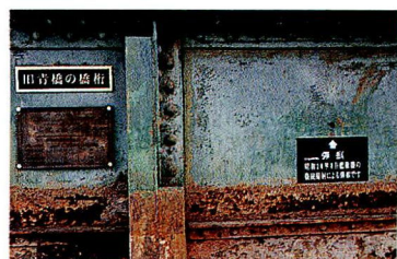
▲旧青橋 ▲青橋 (城内) 今は背景のお城にマッチしたモダンな橋となったが、先代は太平洋戦争の生き証人。機銃の弾が貫通したあとが生々しく残されている。銃弾のあとが残る部分は切り取られ、青橋から200メートルほどの所 (田中組前) に置かれている。
