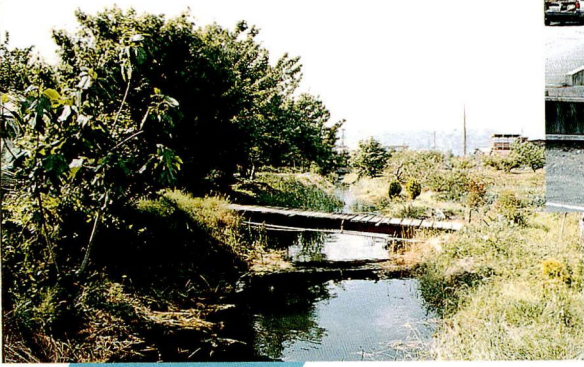
整備前の様子
