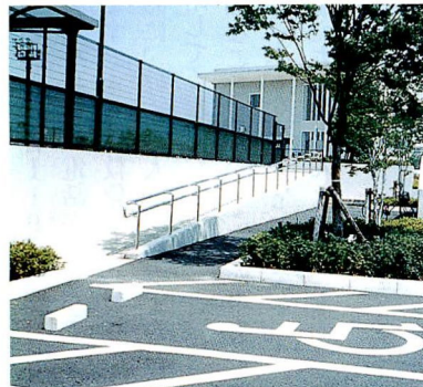
▲駐車場は、出入り口の近接した場所にあり、車いすで利用できる幅の広いスペースになっています。
