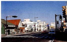
東海道ルネッサンス事業が進む国道1号
