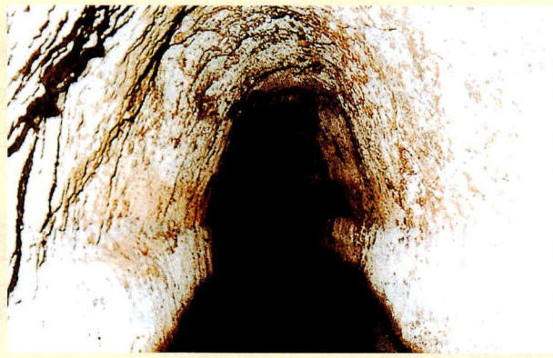
桜田隧道内部
