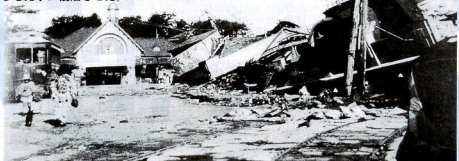
小田原駅前惨状。正面の小田原駅は倒壊には至らなかったが、壁面は落ち、随所に傷みが出たため、大改修を施した。このとき屋上の土が撤去された。 [一枚の古い写真より]
