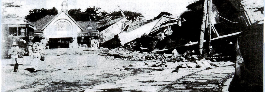
小田原駅前惨状。正面の小田原駅は倒壊には至らなかったが、壁面は落ち、随所に傷みが出たため、大改修を施した。このとき屋上の塔が撤去された。 「一枚の古い写真」より
